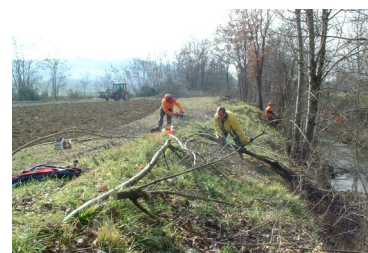
Traitement de la végétation
